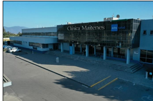
Figura N°6: Fachada Clínica Maitenes Melipilla (2024)
